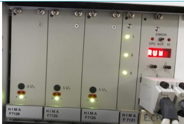
اتصال کانکتور مدباس به پورت‌های سریال CU
